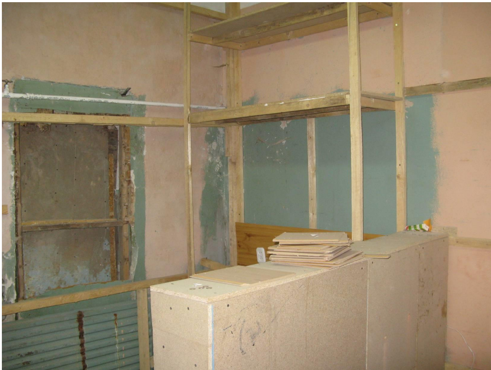
Складское помещение площадью 8,0м2
